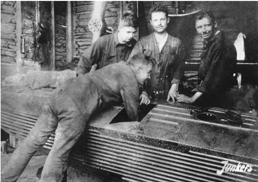
(253) Werner Junkers, Hermann Müller und Wilhelm Thill bei der Reparatur eines Schwimmers
